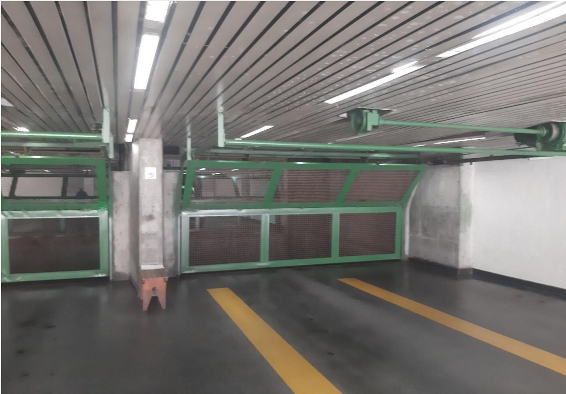
Vista de entrada para a plataforma de acesso
