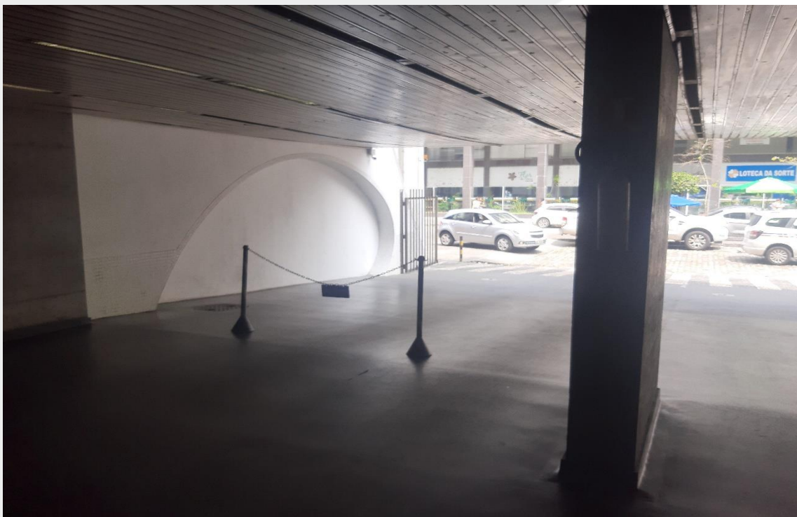
Vista da entrada para o edifício garagem
